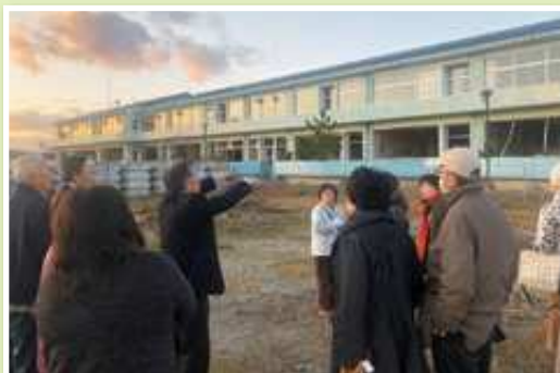
浪江町請戸地区に残っている請戸小学校校舎。津波で1階部分が破壊された。
